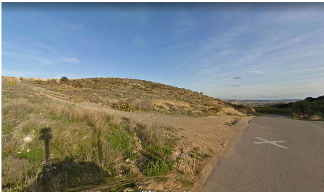
Ilustración 3. Acceso al parque fotovoltaico.
